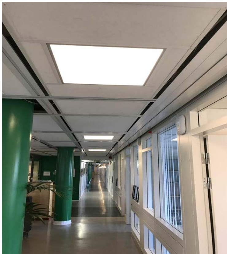
Figur 25. Här har LED-plattor ersatt de lampetter som syns längre bort i korridoren.
