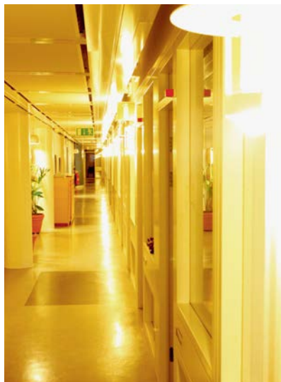
Figur 53. I denna korridor finns lampetter som är avsedda för traditionella glödlampor. Man har dock ersatt glödlamporna med lågenergilampor som är några centimeter längre. Följden blir att de bländskydd som skärmade av glödlampans direkta sken mot den som passerar i korridoren nu sitter fel, lågenergilampornas lysande del sticker ut nedanför bländskyddet (se även Figur 32) och ger en kraftig bländning. Att bygga om armaturerna är inte tillåtet om det innebär att CE-märkningen inte längre gäller.
